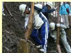
急な斜面での作業
